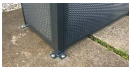
Kotvení modulů
